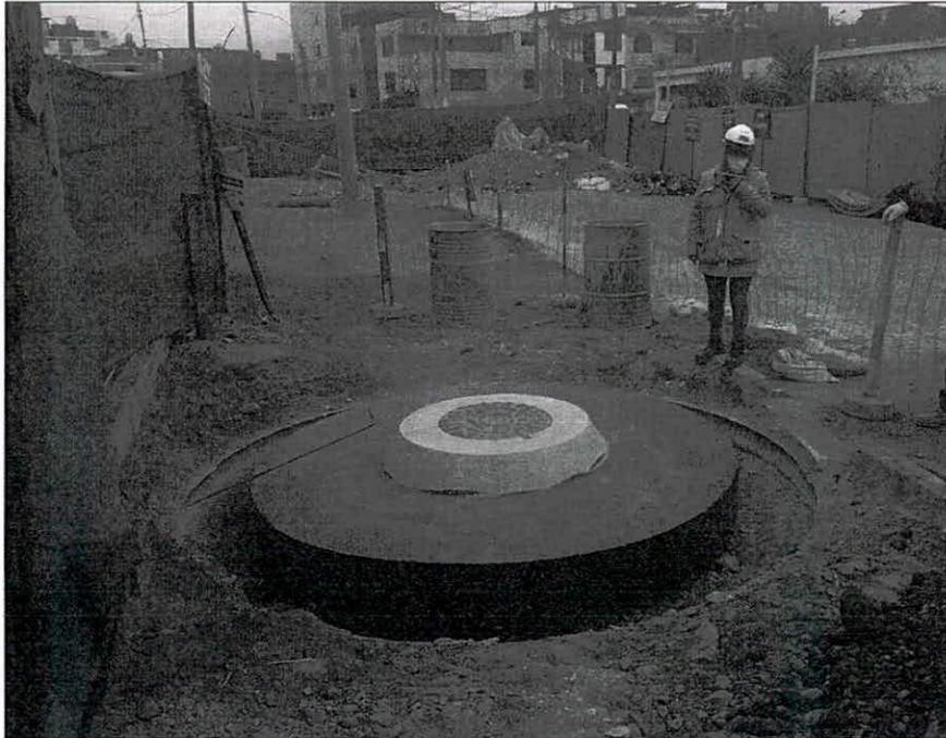
Fig. N°12: Impermeabilización de la Cisterna CIS-01
